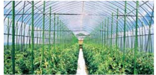
被覆鋼管支柱・鉄線
